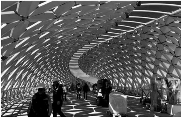
и ветровой нагрузки. Общий вес конструкции – 1920 тонн.
