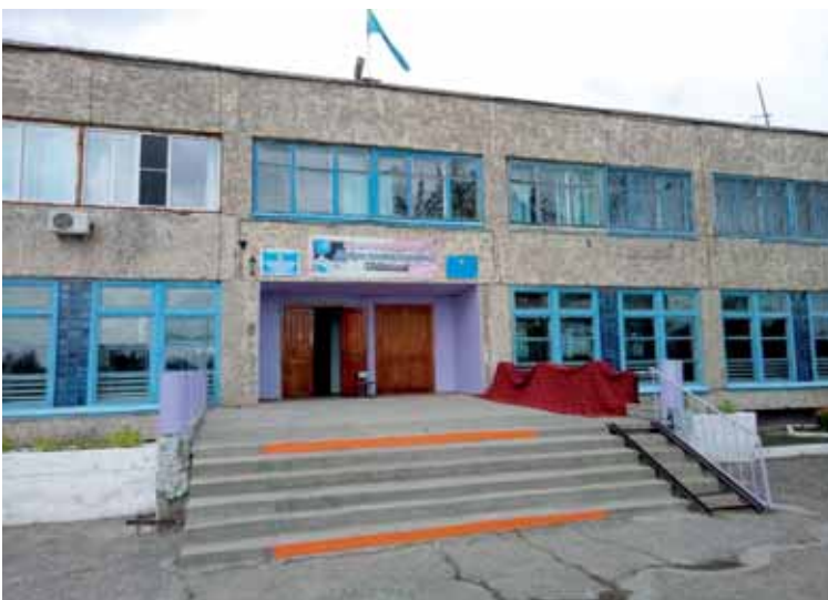
Первоначально ремонт кровли школы оценивался в сумму более 47 млн тенге, а замена канализации – около 43 млн тенге. Однако при утверждении бюджета города на 2018 год сумма, предназначенная для капитального ремонта в СОШ №34, не была заложена. Фото автора
