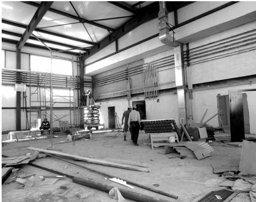
Реконструкция аэропорта должна быть завершена в декабре 2018 года. В настоящее время подрядчики укладываются в этот срок. Фото: автора
