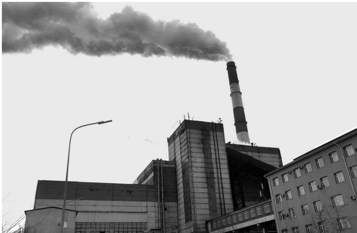
В акимате Астаны рассчитывают, что газификация, помимо решения проблем с ценами на уголь, позволит решить еще одну беду столицы – смог. Пока же городские власти увеличили высоту труб городских ТЭЦ до 120 метров с тем, чтобы дым рассеивался на большей высоте. Фото: Аскар АХМЕТУЛЛИН
