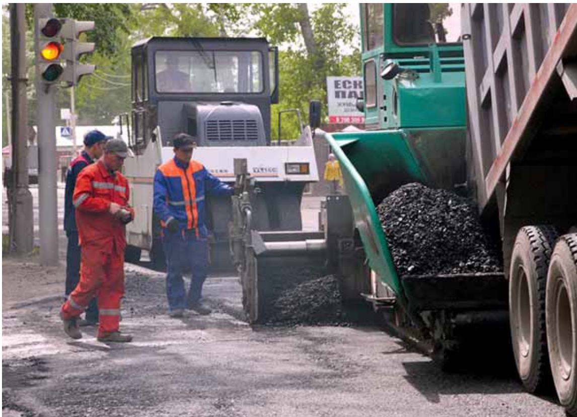
Главным вектором развития дорожной сети области на предстоящие четыре года должно стать асфальтирование дорог, находящихся в неудовлетворительном состоянии. Фото: Дмитрий КУЗМИЧЕВ
