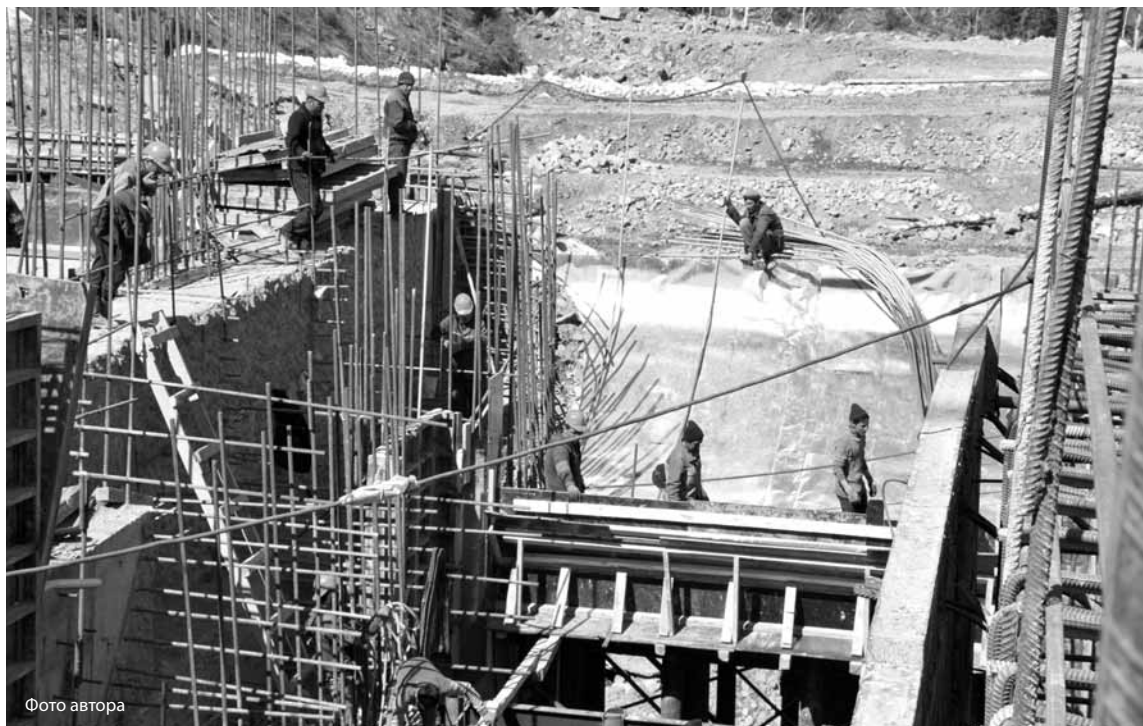
Ущерб, нанесенный паводком в 2018 году, строители ГЭС оценивают в 100 млн тенге.
