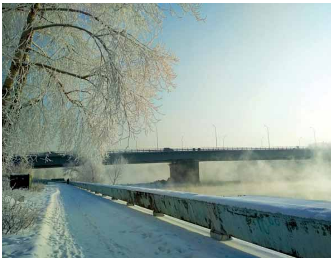
Новый Иртышский мост Усть-Каменогорска должен был разгрузить движение при проезде в левобережную часть города. Но без современных транспортных развязок цель не достигнута. Фото автора
