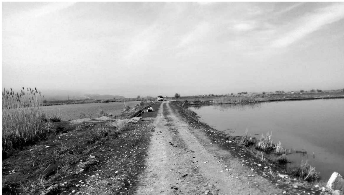
биной один-два метра прямоугольные бассейны. Размеры этих и построенных позже карт, которых сейчас 92 единицы, – 80 метров в ширину и 175–240 м в длину. По мере роста объемов сточных вод увеличивалась и площадь полей фильтрации: в 1978 году добавили еще 28 карт, в 1986-м – 12, а в последний раз, в 1991-м, еще 26.
