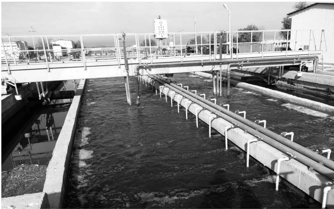
тыс. куб. м сточных вод в сутки. Однако, учитывая стремительный рост Шымкента, на очистных сооружениях провели модернизацию: построили вторичный радиальный и первичный отстойники и аэротенки объемом на 50 тыс. куб. м канализационной воды в сутки, а также горизонтальные песколовки для удаления песка и жира и комплекс по переработке осадка, с выработкой биогаза и получением электроэнергии.
