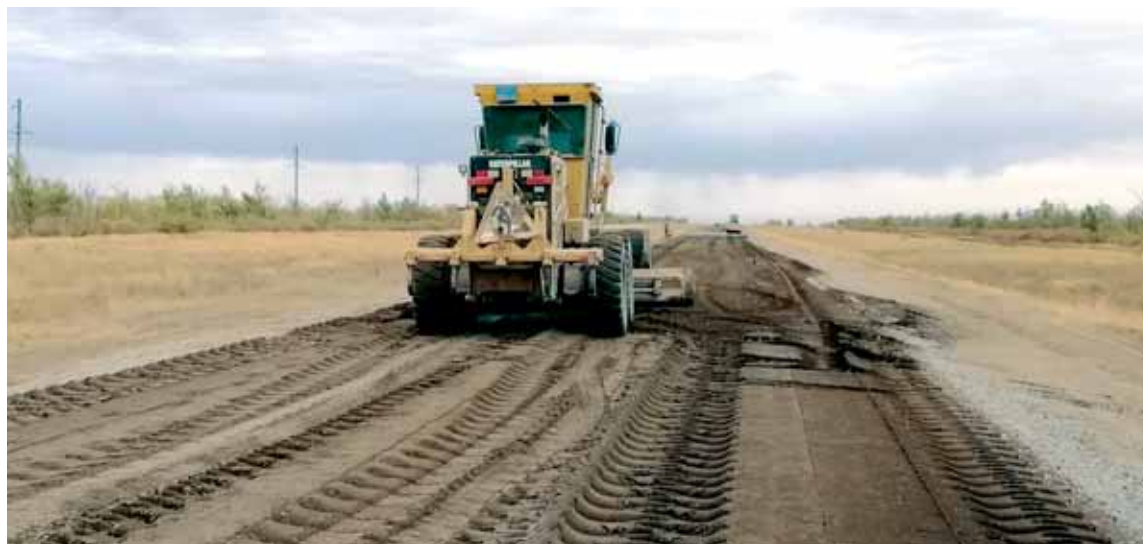
Трасса на Атырау имеет большое значение для движения транзитного транспорта, поэтому за качеством строительства будут следить специалисты Управления автодорог и технадзора. Фото автора
