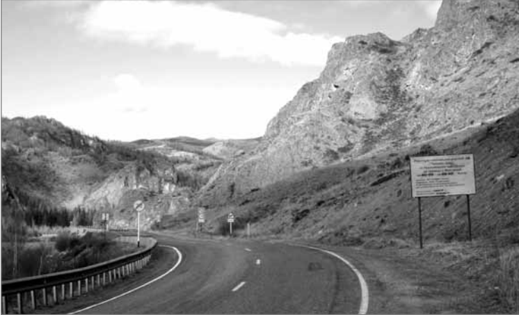
2017—2019 годы станут пиковыми по объемам строительства дорог
