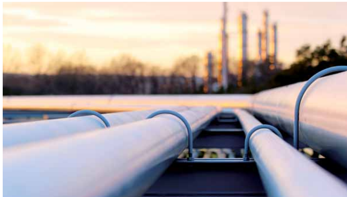
Разработка документации по строительству магистральных и внутрипоселковых газовых сетей обошлась области в 89 млн тенге. Shutterstock/Kodda
