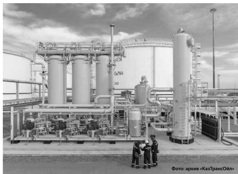
Установка рекуперации паров на НПС им. Н. Шманова Атырауского нефтепроводного управления.
