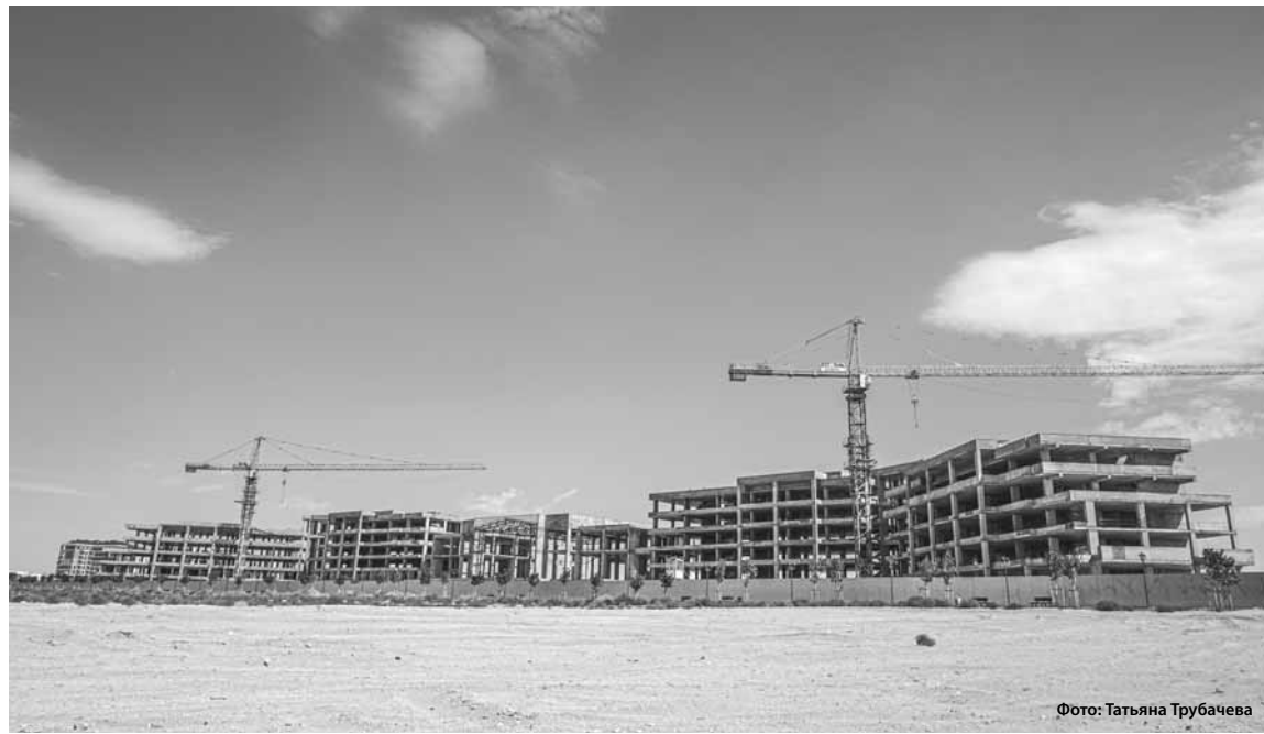
Строительство отеля Fairmont в Актау остановлено.
