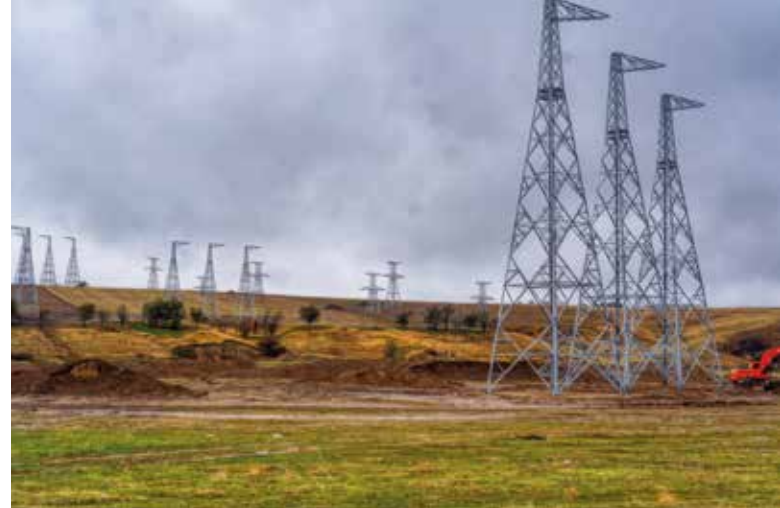
Строительство ВЛ-500 кВ и 220 кВ для электростанции на базе ПГУ в Туркестанской области, 2024 г.
